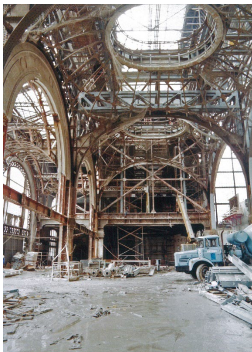
Mise à nue de la structure métallique en avril 1981. Travaux d'aménagement vers 1983.
