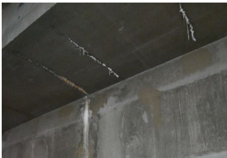
Fissuration en sous-face du parvis Lille.
