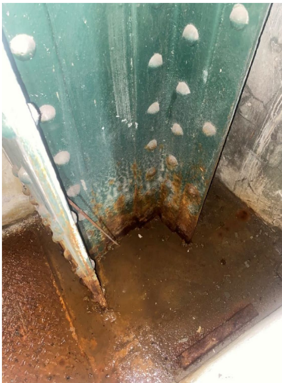
Humidité stagnante et corrosion en pied du poteau.
